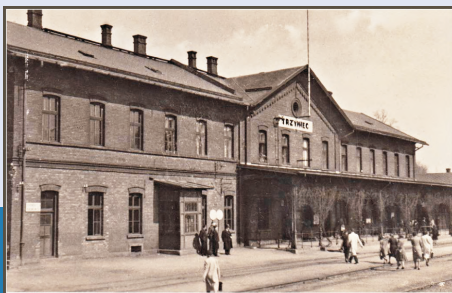
◀ Původní výpravní budova, Třinec, rok 1938 – 1939
