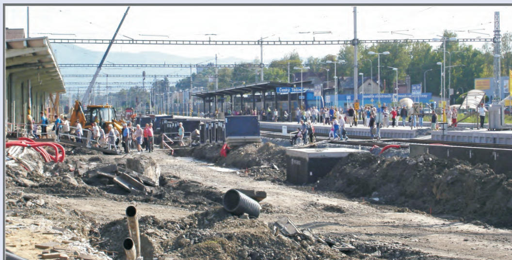
◀ Cestující na staveništi v železniční stanici Český Těšín, 2015
