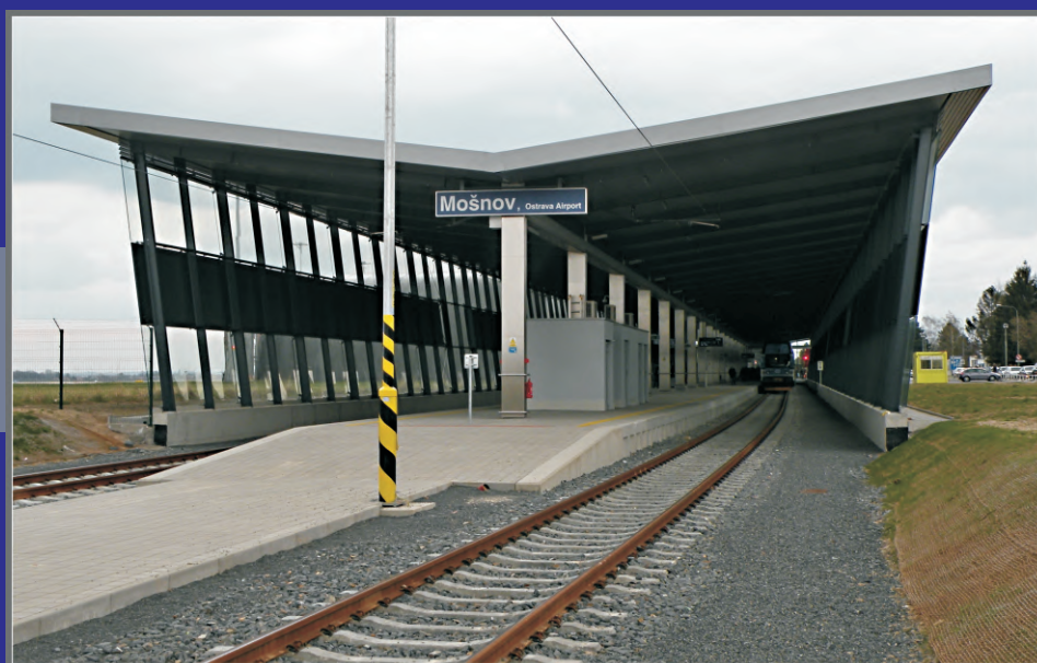
Nový terminál železniční zastávky Mošnov, Ostrava Airport, 2015
