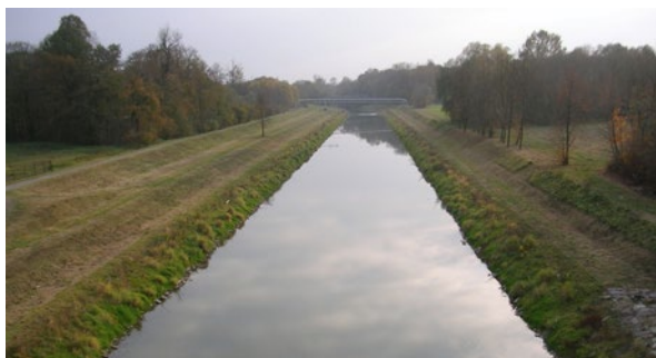
Obr. 7.1.3.5 Skanalizowana Odra między jazami Proskovice i Svinov – stan obecny (szerokość ok. 20 m, głębokość ok. 1 m) można stosunkowo łatwo rozszerzyć do parametrów drogi wodnej klasy Vb, zdjęcie Ivan Hošek
