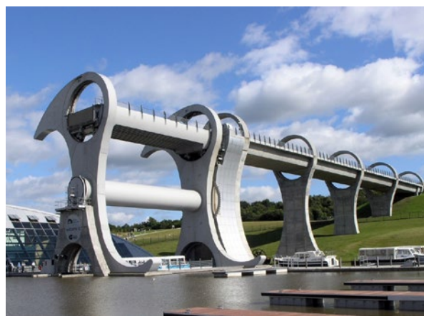
Obr. 4.5. Kultowa winda obrotowa w szkockim Falkirk
