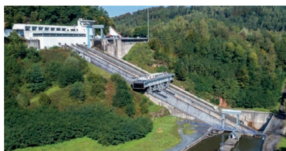
Obrázek 4.4 Vana šikmého lodního zdvihadla v Arzwilleru na vodní cestě Marna-Rýn
