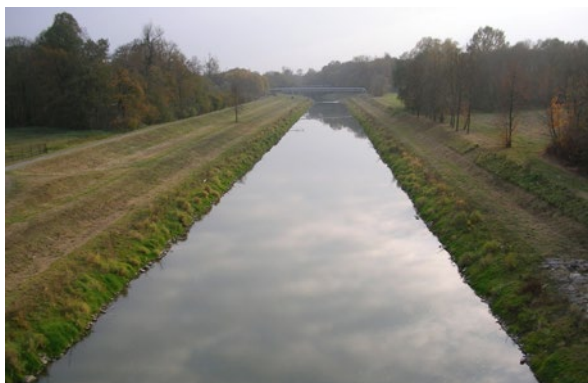
Obrázek 7.1.3.5 Kanalizovaná Odra mezi jezy Proskovice a Svinov – současný stav (šířka cca 20 m, hloubka cca 1 m), lze poměrně snadno rozšířit na parametry vodní cesty tř. Vb., foto Ivan Hošek
