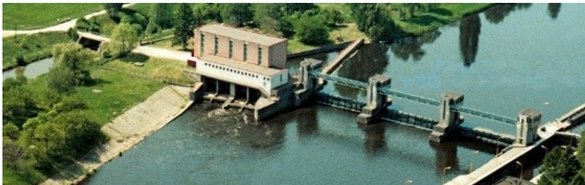
Obr. 7.2.1 Ilustrační foto: jez s vodní elektrárnou a plavební komorou.
